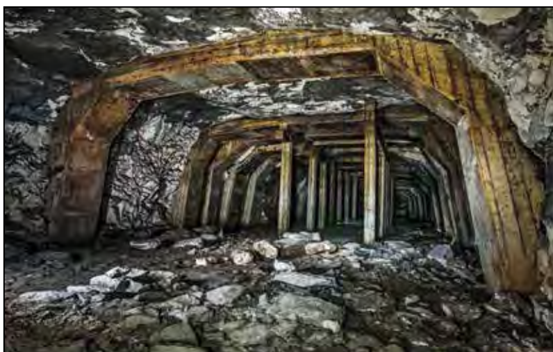
Prostory podzemní továrny Elsabe (stavební úsek Richard I), snímek z roku 2017. Foto Alex Desp.
