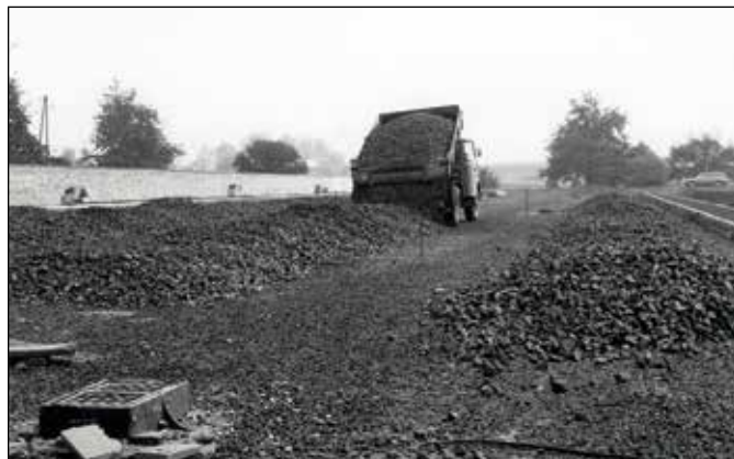
Výstavba parkoviště před Malou pevností, podzim 1974. Construction of a car park in front of the Small Fortress, autumn 1974.
