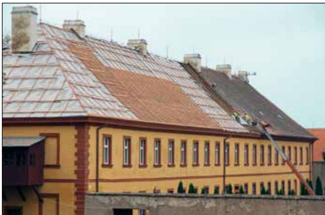
Rekonstrukce střechy budovy správy Památníku Terežín v roce 2014. Reconstruction of the roof of the building of the Terezín Memorial's administration in 2014.
