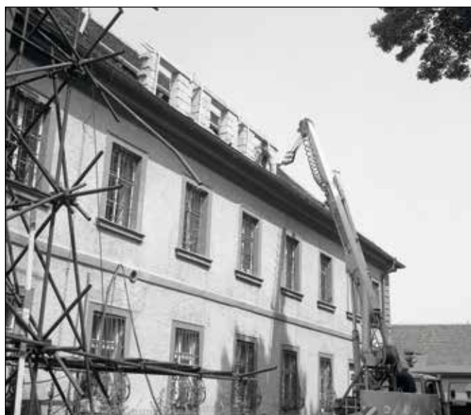
Budování deponitáře na půdě Muzea Malé pevnosti v roce 1980. Building a depository in the attic of the Small Fortress Museum in 1980.
